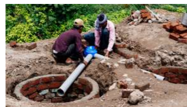
V-Trapを施工する様子
