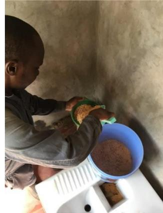
「グリーントイレシステム」は、排泄物を液体と固体に分離して安全に処理し、肥料および土壌改良剤として再利用することを可能にしています。
