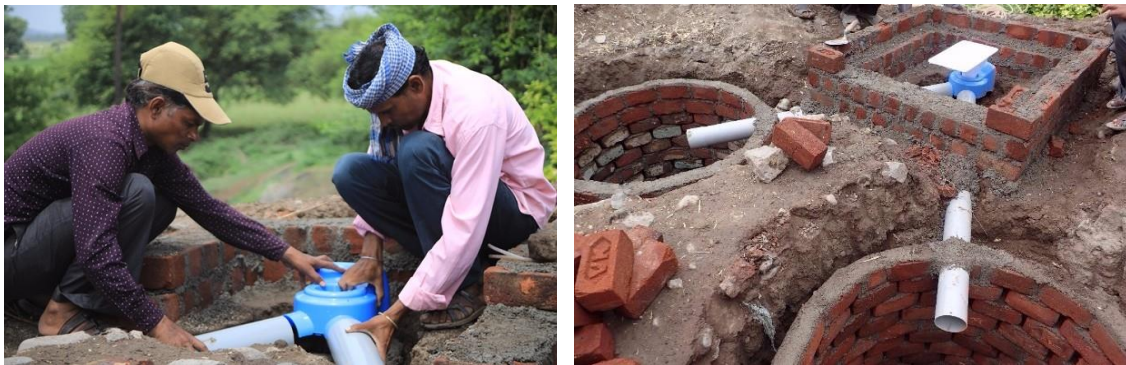
2ピットシステムに対応する「SATO V トラップ」の現地での施工の様子
