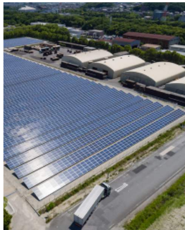
LIXIL知多SOLAR POWER (2018年3月期年間発電量 約6,300MWh)
