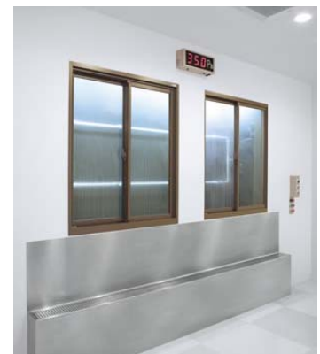
«Inside the Water & Air-tight Space»
