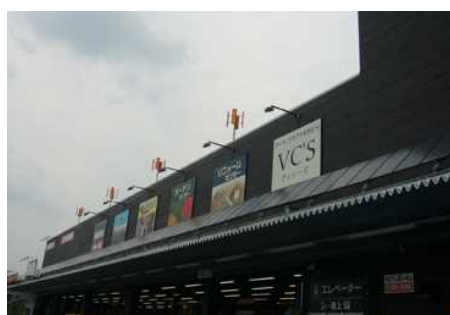
▲スーパービバホームの太陽光パネルと風力発電
